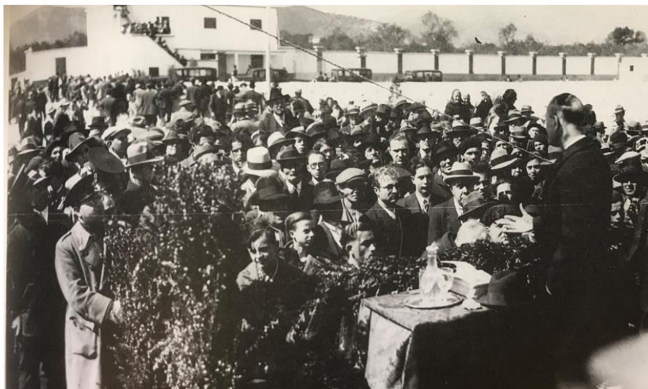
Inauguració dels dipòsits d'aigua de Son Togores, el març de 1934. Ubicats a la cruïlla de la carretera Palma-Valldemossa. Darder hi assistí com a batle i organitzà un servei de transport per a que hi pogués assistir públic. Font: Del Hoyo Bernat, X., Company Matas, A. (2005). Palma 1931-1936. L'evolució de la ciutat a través de la imatge . Institut d'Estudis Balearics.
